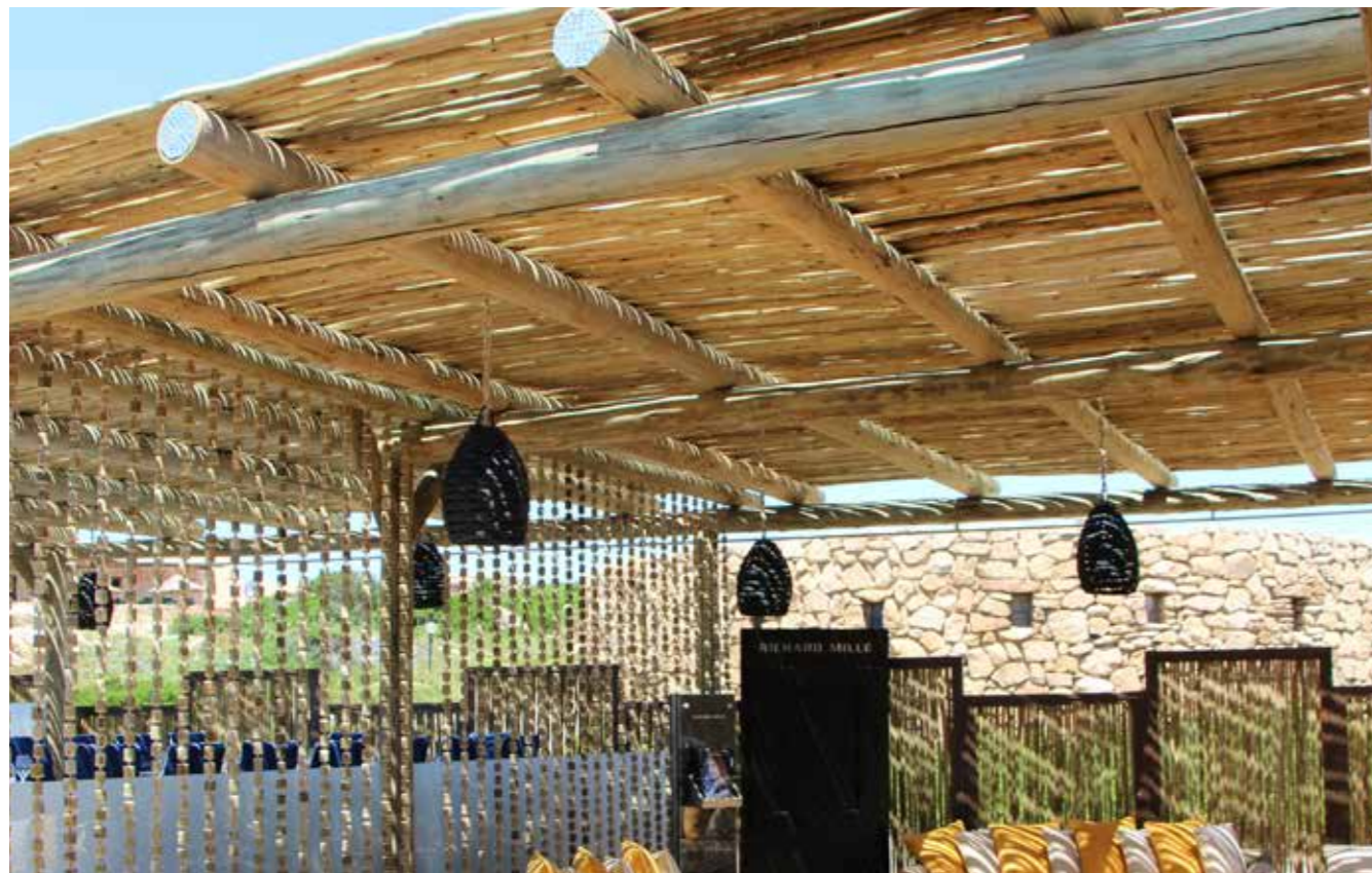
Es. di resa della copertura a rotolo / Ex. of roll covering results
